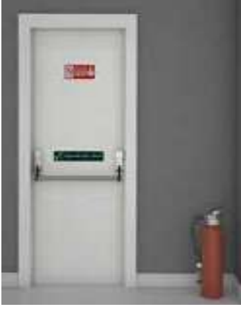
Şekil A.11.1: Acil çıkış kapılarının işaretlenmesi
