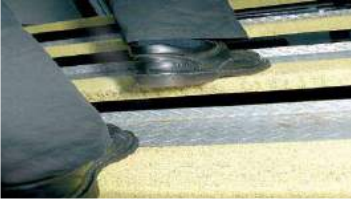
Şekil A.6.6: Kaymaz zemin kaplamalı merdiven örneği
